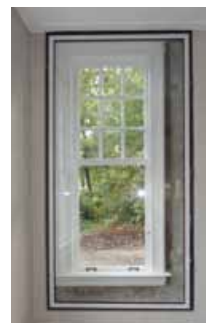
Achterzetramen voor het behoud van de oorspronkelijke kozijnen.
